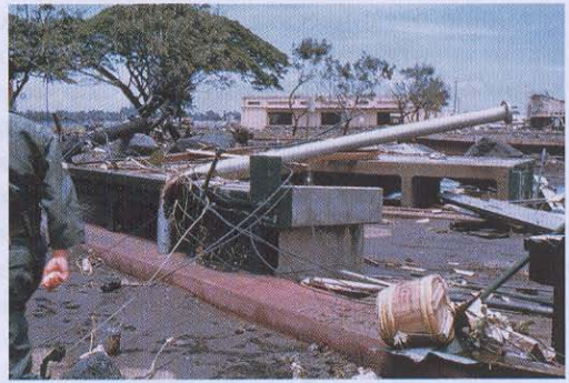
Разрушения, причиненные цунами в гавайском поселке Хило (1960).
