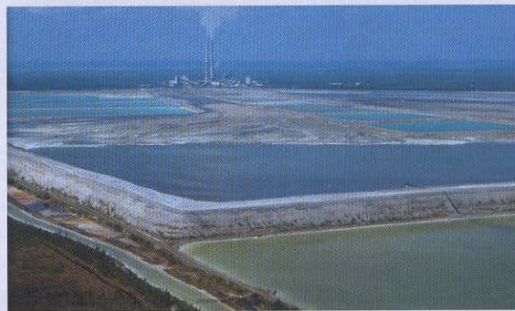
На теплоэлектростанциях воду используют для охлаждения, а также, например, для транспортирования отходов в отстойные бассейны (на фотографии).
